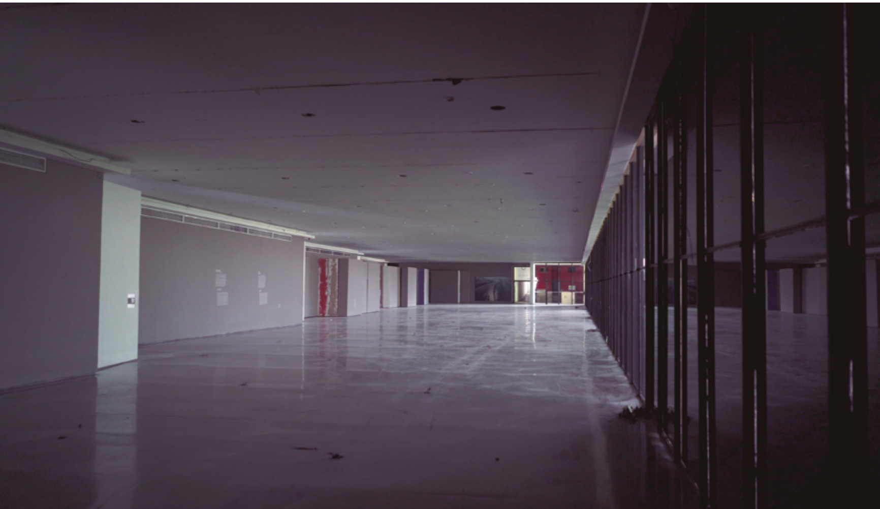
Sala Milú Villela esvaziada para reforma da marquise.
