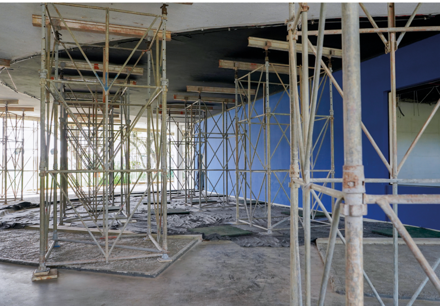
Sede do MAM em reforma.
